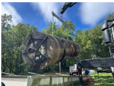
Renouvellement partiel du Biodisque STEP de GREOLIERES VILLAGE
